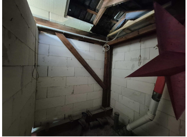
Raum für ein mögliches WC im DG
