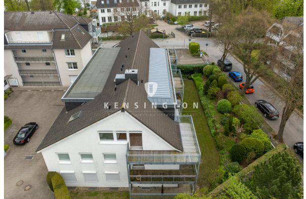
Luftansicht mit Balkon
