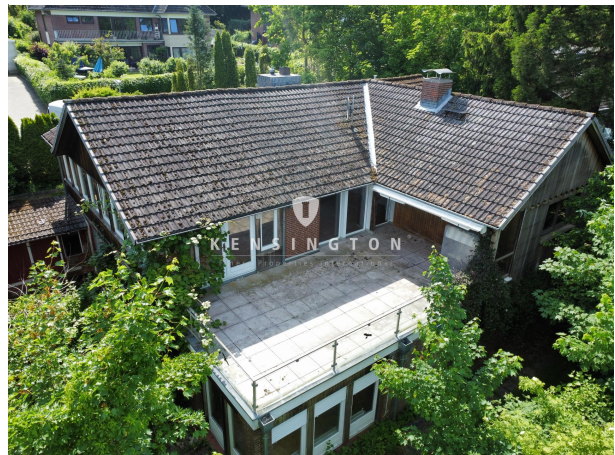
Hausansicht mit Terrasse
