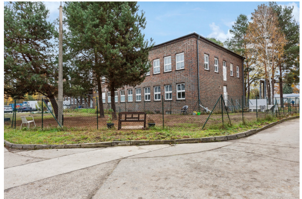
Gebäudeansicht von hinten
