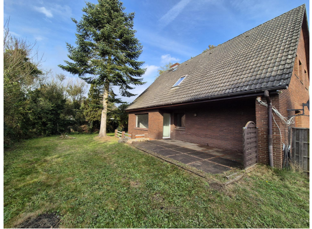
Hausansicht mit Terrasse
